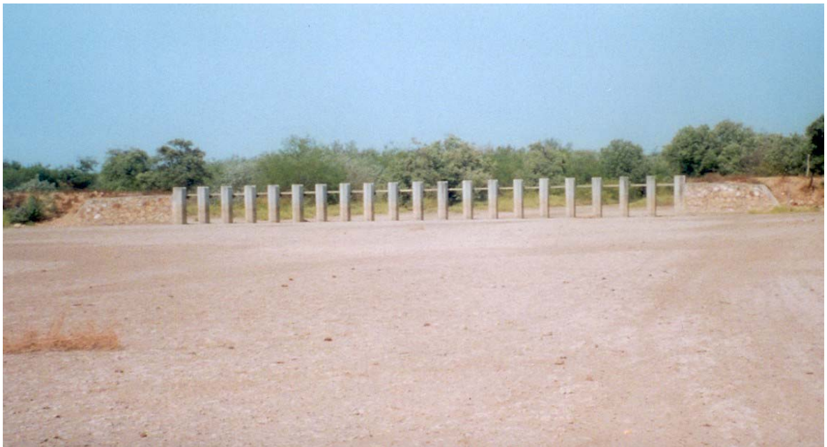
Fig.39. Estructura de control hidráulico empleada en los tapos huaves (ikoot´s). 1995.
